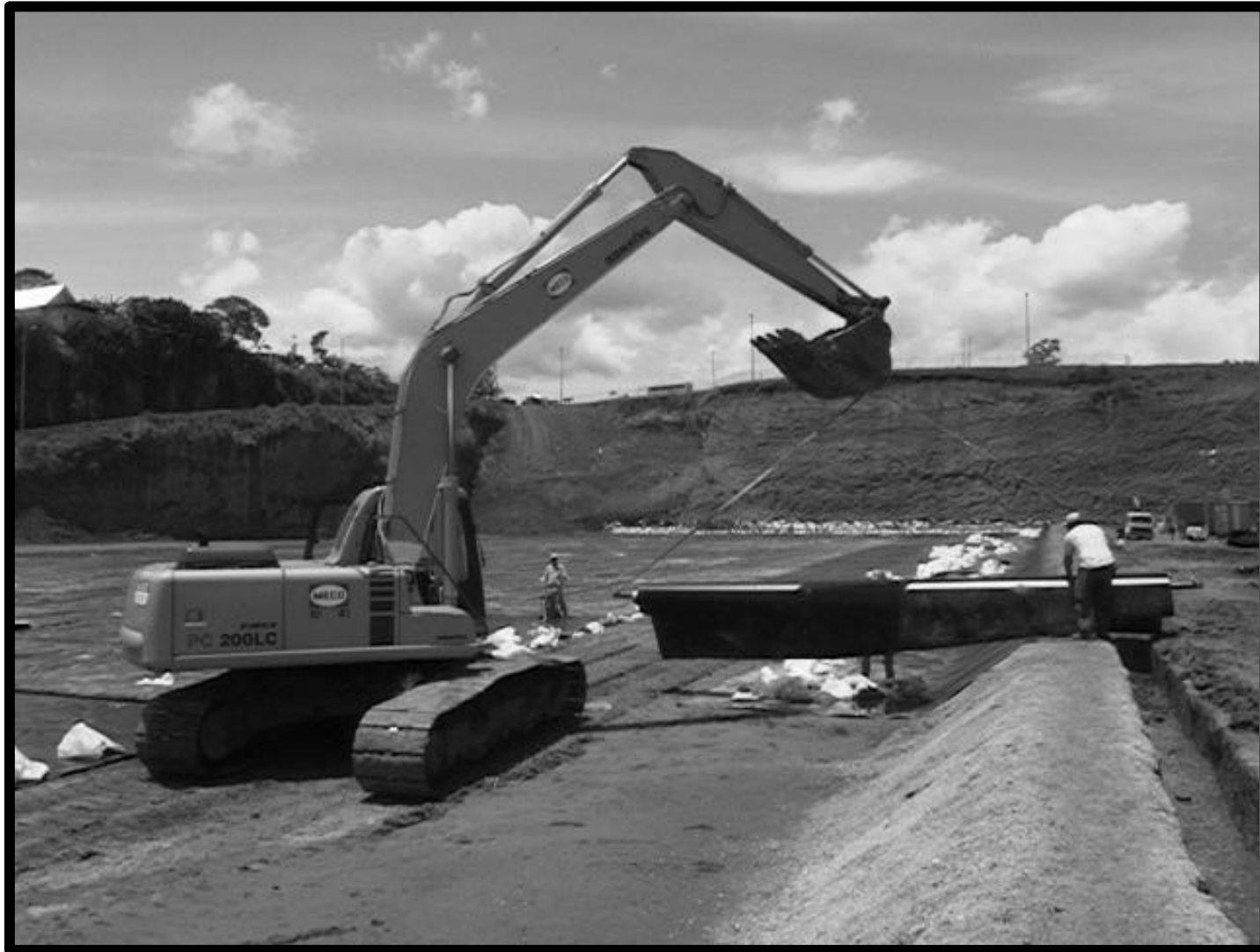
Colocación de la geomembrana (geom).
