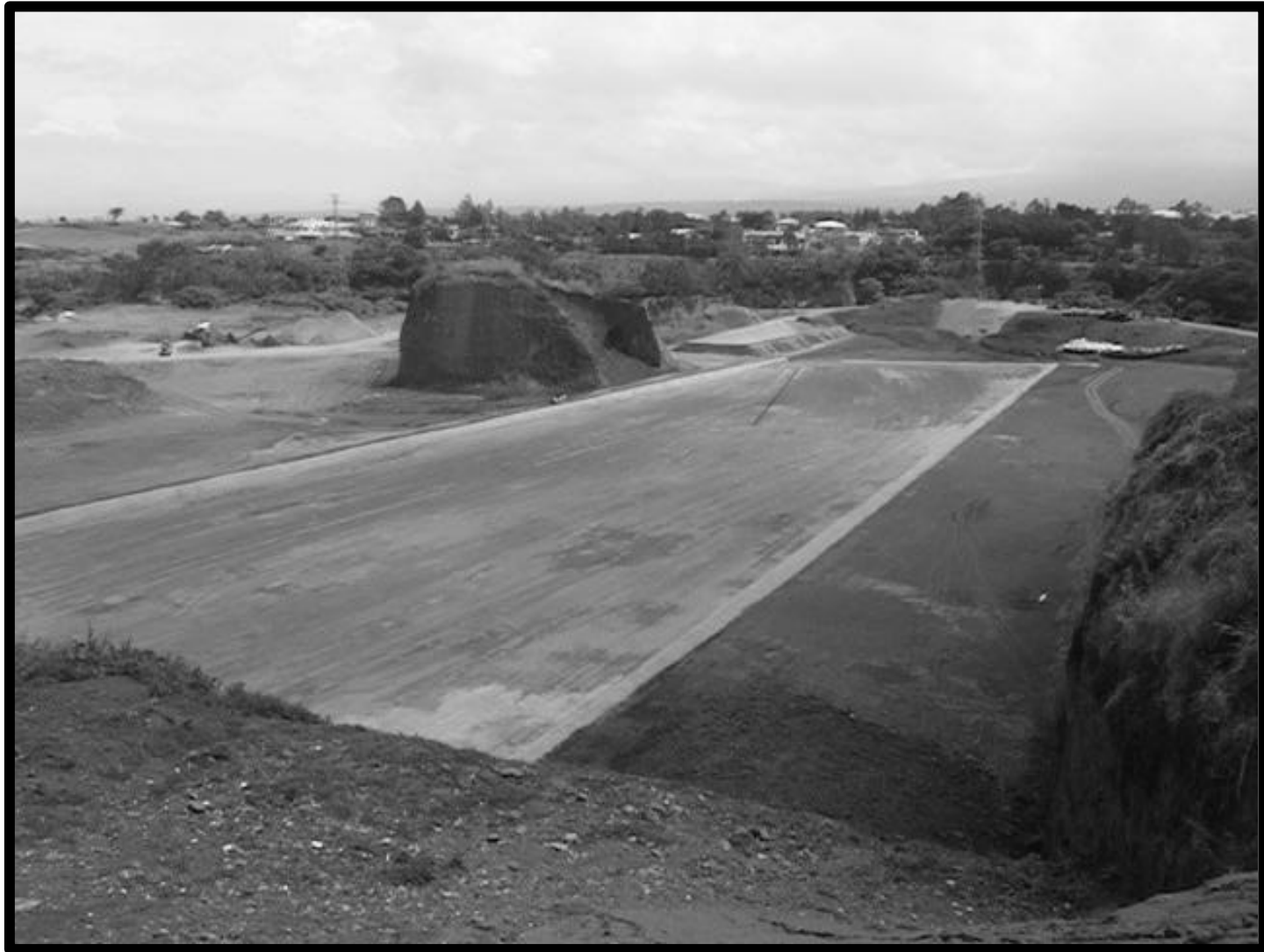
Base conformada para la colocación de la Geomembra. Arcilla con un grosor de 60 cm.
