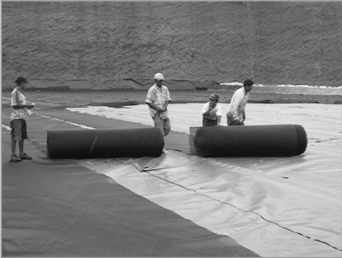
Instalación de la Geonet
