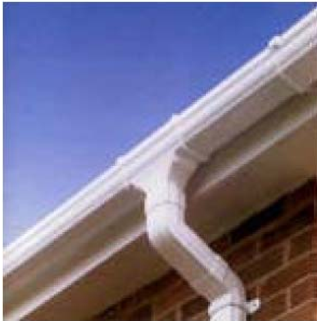
Figura 2. Canaletas de recolección
