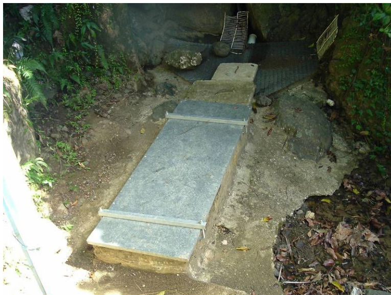
Figura 4.28. Represa del Tanque #3 con mallas de retención – Comunidad Lijas, Las Piedras.
