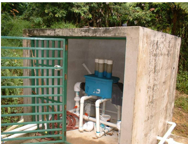
Figura 4.17. Clorador de Tabletas – Sector El Veinte, Yabucoa (foto por Sr. Ricardo Coreano – enero 2003).
