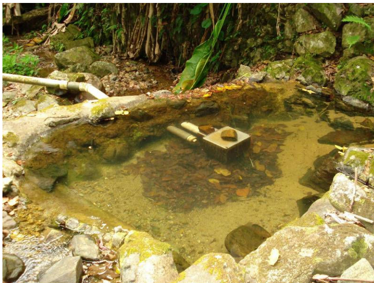
Figura 4.16. Represa con Caja de Acero Inoxidable – Sector El Veinte, Yabucoa (foto por el Departamento de Salud – junio 2007).
