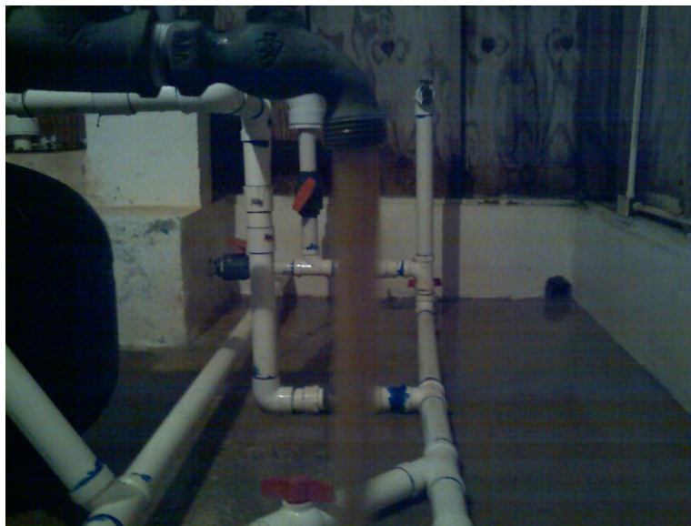
Figura 4.25. Agua Turbia Proveniente de los Filtros Lentos de Arena – Comunidad Lijas, Las Piedras (foto por E. Montañez-julio 2007).
