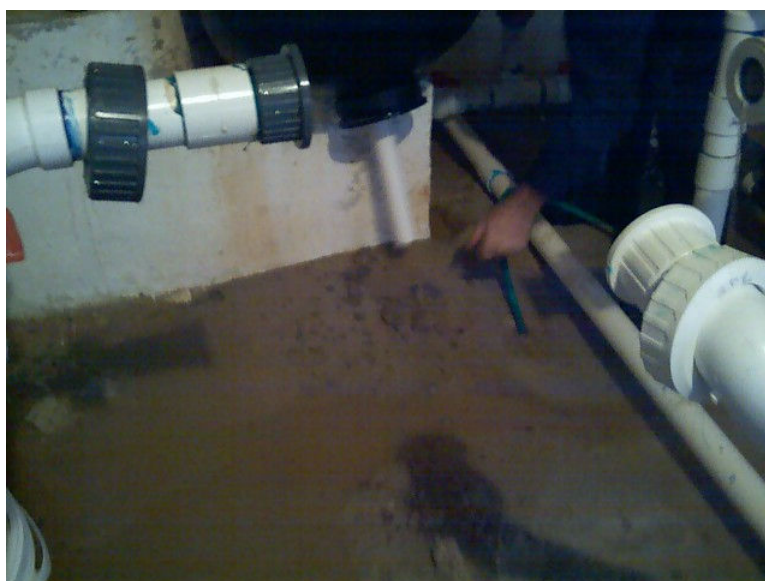
Figura 4.26. Arena de Sílica Proveniente de los Filtros Lentos de Arena – Comunidad Lijas, Las Piedras (foto por E. Montañez- octubre 2007).
